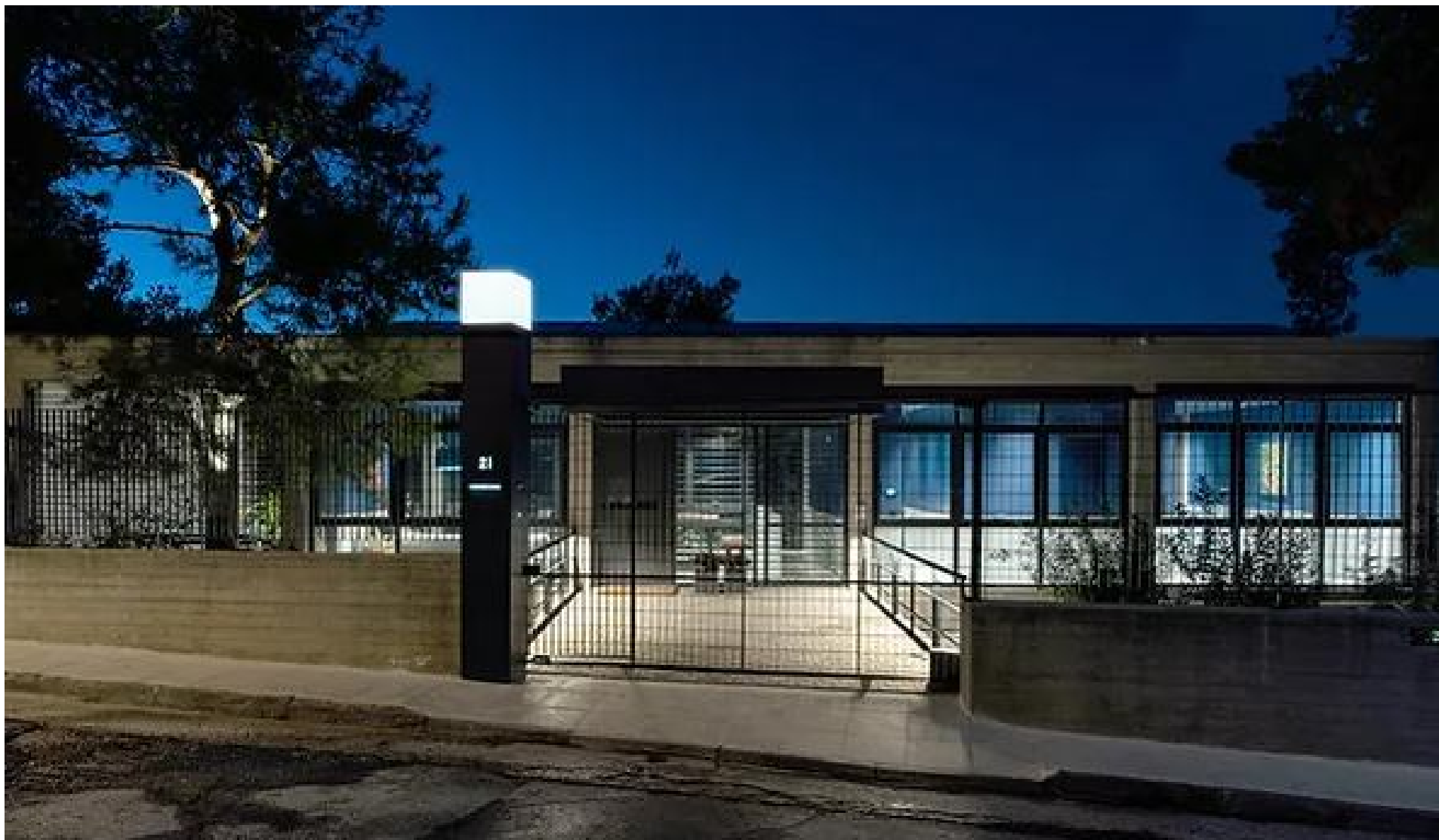
εικ.9 Νυχτερινή άποψη από Βορειοανατολικά / Είσοδος.
