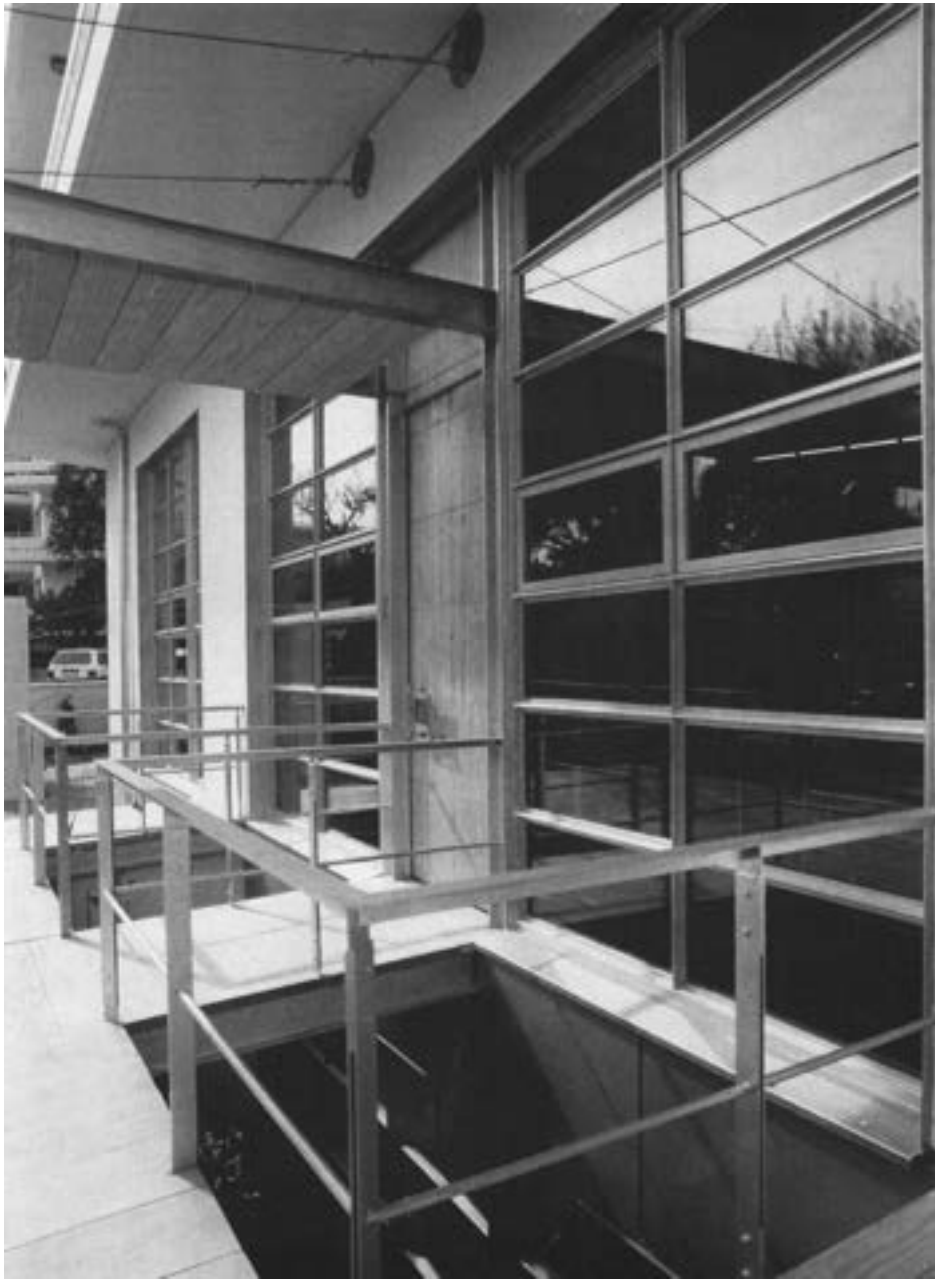
εικ.1 Βόρεια Όψη / Είσοδος.
